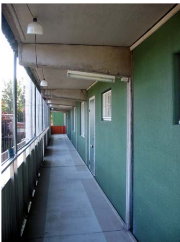
Figur 19. Den vänstra bilden visar den befintliga loftgången och den högra bilden visar balken som bär upp loftgångens betongplatta.
