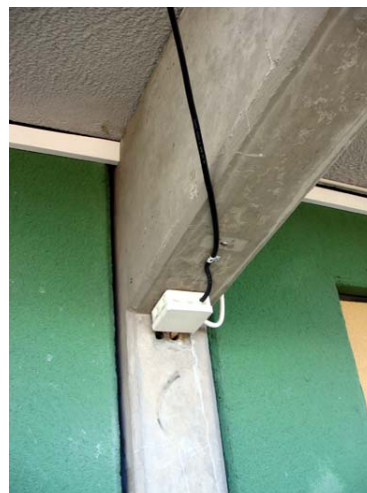
Figur 19. Den vänstra bilden visar den befintliga loftgången och den högra bilden visar balken som bär upp loftgångens betongplatta.
