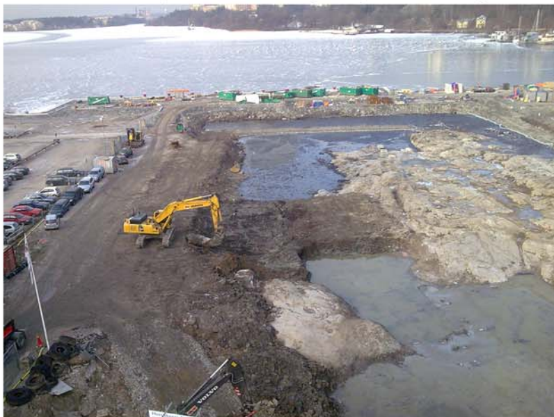
20090218 Bild006 Schaktbotten i område A sett från intilliggande byggnad.jpg
