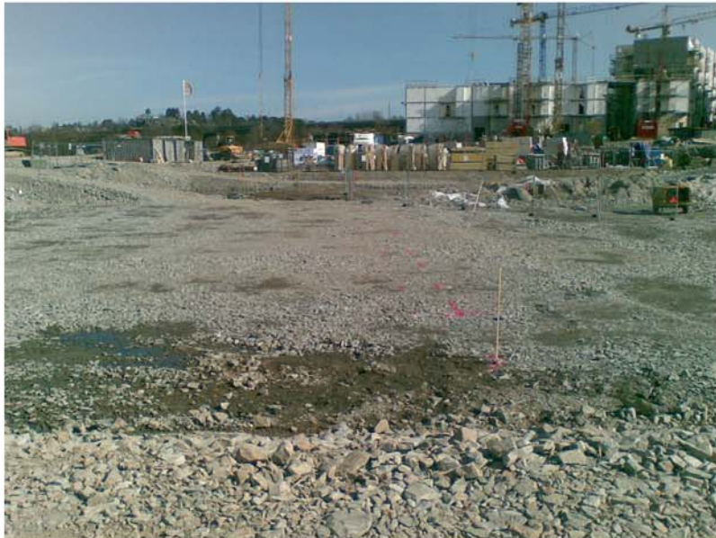
20090403 Schaktbotten område A efter återfyllning.jpg
