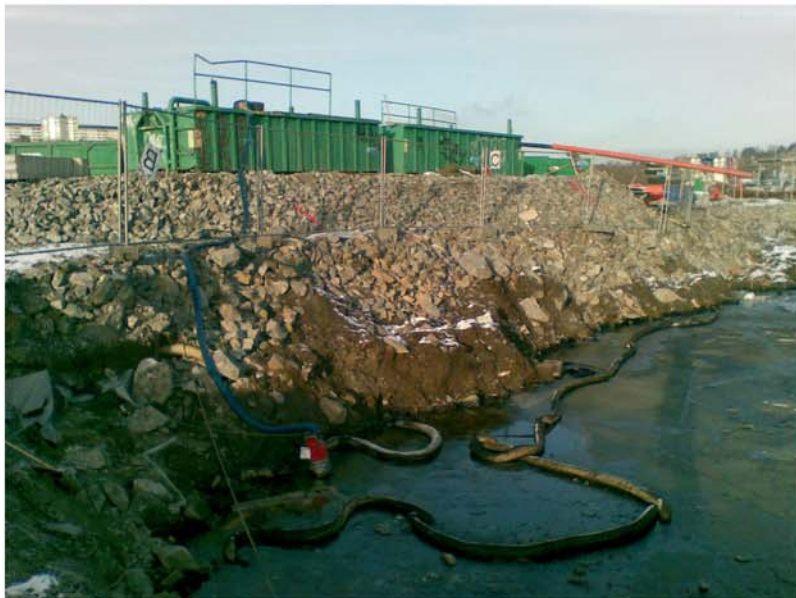
20090203 Vattenbehandling i schakt invid nyanlagd mark i tidigare strandlinje.jpg
