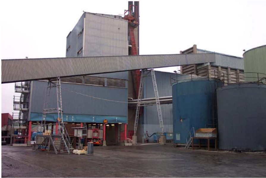
01 Asfaltverket i drift.jpg
