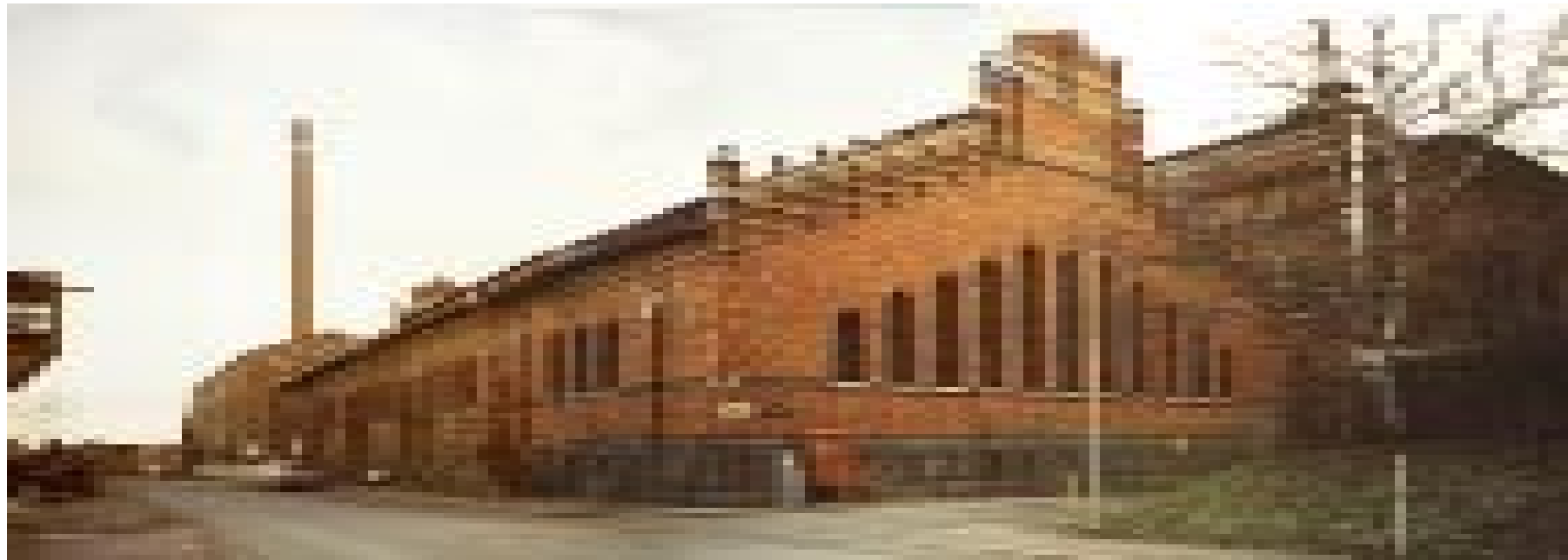
Reningshus vid Gasverksområdet
