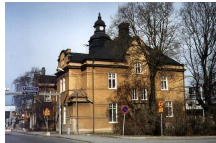
Fd tull- och hamnkontor ("kommunalhuset") i Södra Värtahamnen
