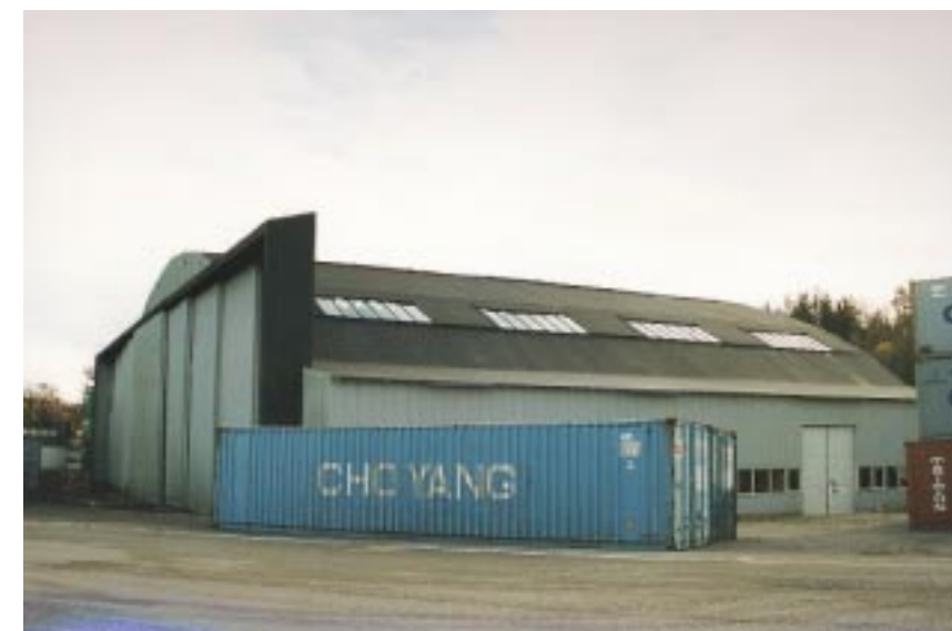
Lindarängshangaren vid Containerterminalen
